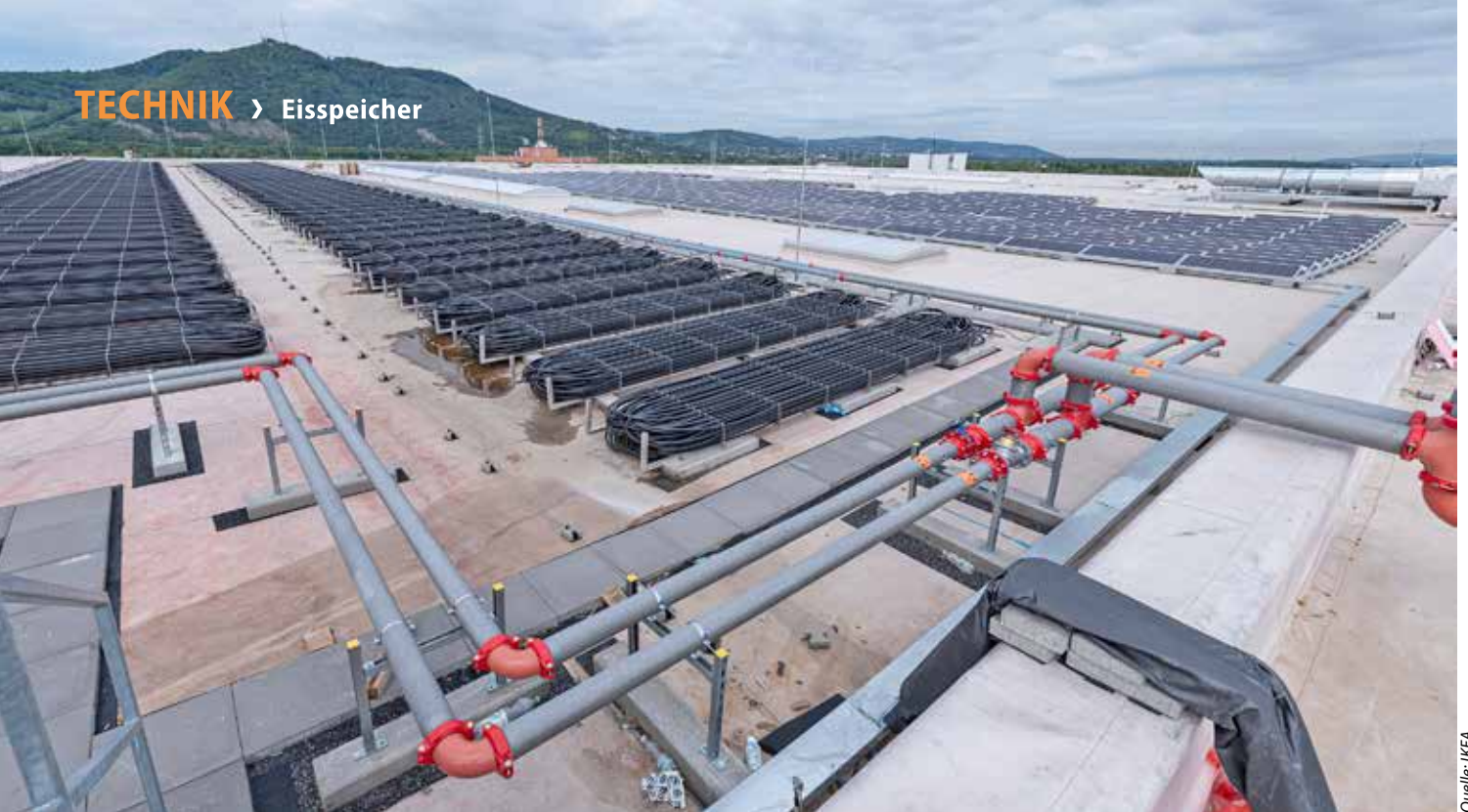
172 Solar-Luft-Kollektoren und 3.350 PV-Module auf dem Dach des IKEA-Auslieferungslagers
