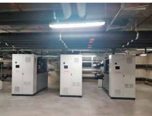
Viessmann-Wärmepumpen entziehen dem gespeicherten Wasser die Wärme.
